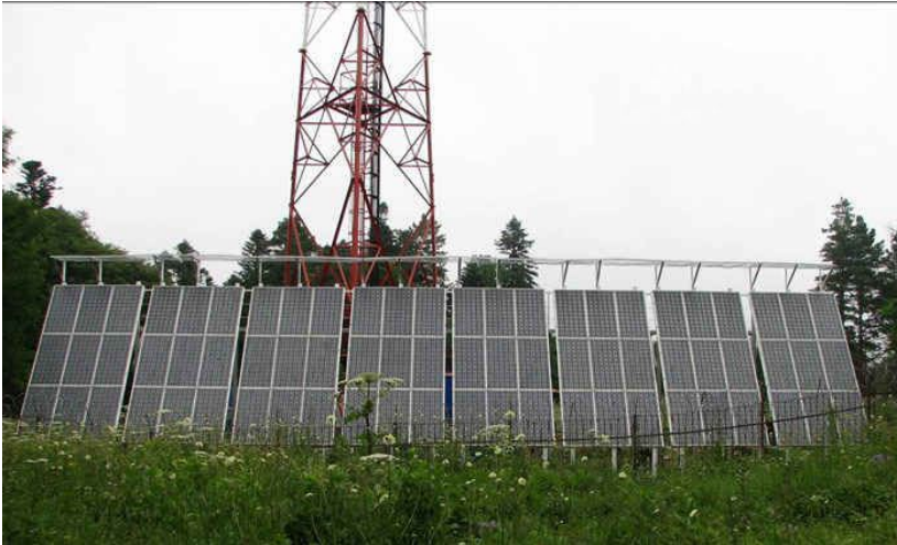
Рисунок 1 – Изображение установки солнечных панелей на базовой станции
