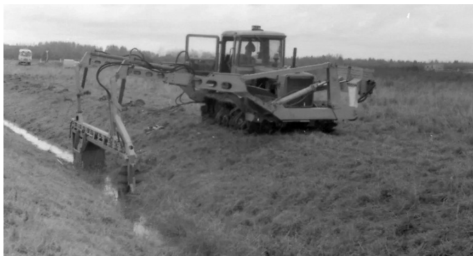
Рисунок 1 – Очистка дна канала русловым ремонтром PP-303
