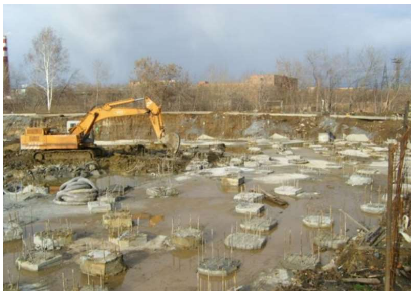
Рисунок 1 – Устройство армирующих бетонных элементов геомассива
