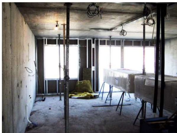
Рисунок 12 – Смонтированный каркас КОС в здании
